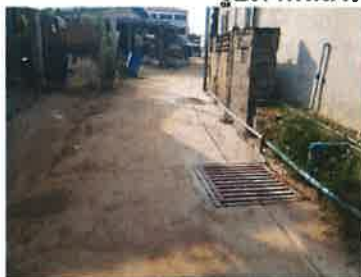
รูปภาพหลังดำเนินงานเสร็จ
